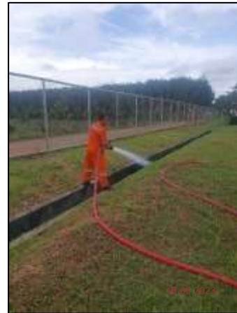
ภาพถ่ายที่ 2.2-11 การลอกท่อและร่องระบายน้ำในเขตสนามบิน
