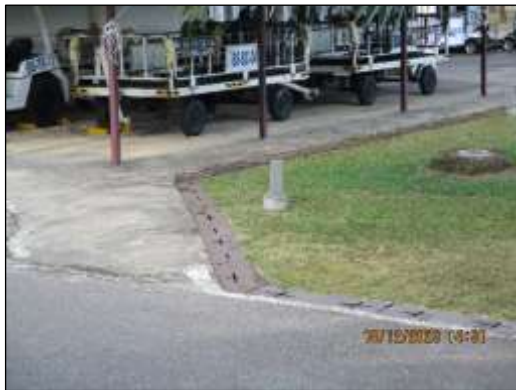
ภาพถ่ายที่ 2.2-10 ร่องระบายน้ำและฝาปิดด้านบนร่องระบายน้ำ
